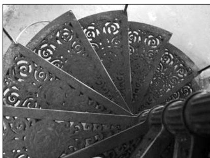
Trittstufen in der Aufsicht
