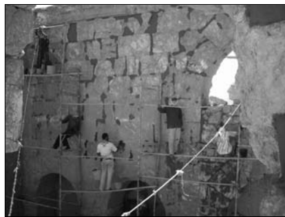
Abb.3: Handwerker während der Konservierung der Südtoranlage, Sep. 2006.
