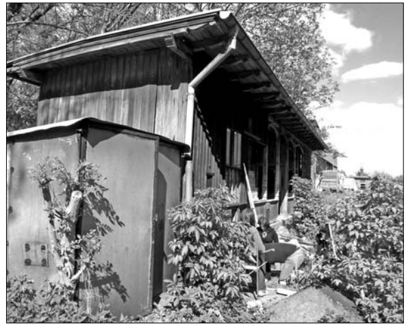
Blankenfelde, Sondage an der Liegehalle, 2007.
