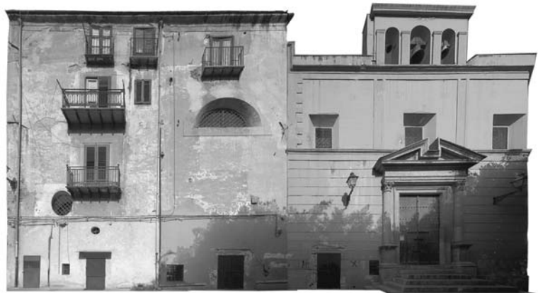
Abb. 1. S. Giovanni dei Napoletani, Gesamtansicht der Seitenfassade (Untersuchungsfläche als entzerrtes Foto), 2007.
