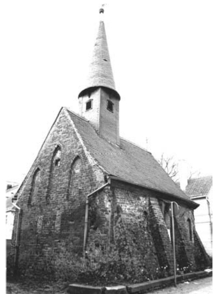
Kapelle St. Georg mit Blick auf den Westgiebel und die Südfassade, 2007.
