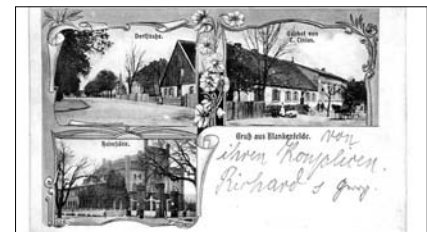
Abb. 5 Blankenfelde und seine Bauten um 1900: Dorfsau/Hauptstraße (Blick von Osten), Gasthof und Eingangsbereich der Heimstätte (Postkarte aus der „Sammlung Peter Rahn, Blankenfelde“)
