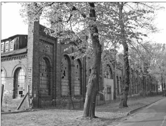
Die ehemalige Giesserei in Tangerhütte, 2007.
