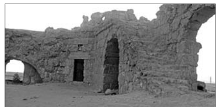
Abb. 4. Blick von Nordwest, die zu Turm 1 führende Treppe, 2007.
