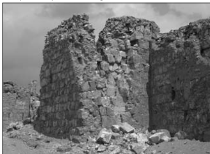
Abb. 1. Turm 33, Feldseite, Blick von Südwest, 2007.
