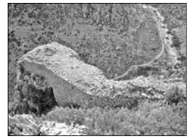
Abb. 5 Turm (Zm_T2) Blick von Südwesten
