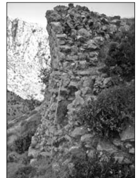
Abb. 4 Toranlage (Zm_K1 - Zm_T1) Ansicht des Torbogenansatzes
