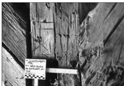
Abb. 7. Wolfshagen, Gutscheune von 1680 (d), Abbundzeichen am Mittelständer der westlichen Scheuneflurbundwand. Da bei der Bezeichnung nach Zeichenarten unterschieden wurde, finden sich an den Mittelständern beide Zeichenarten (röm. Ziffern und Stiche), 2002.
