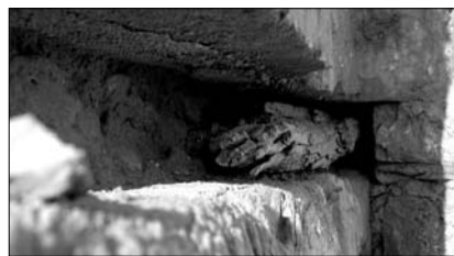
Zentralbau, Holzbalkeneinlage in Risaliten des Nordostturmes, 2007.
