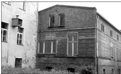
Stadtgut Blankenfelde, Haus 5, Süd- und Westfassade mit angrenzendem Heimstättegebäude im Mai 2007
