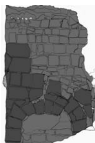
Südwand, Wand c, o.M. 2007.
