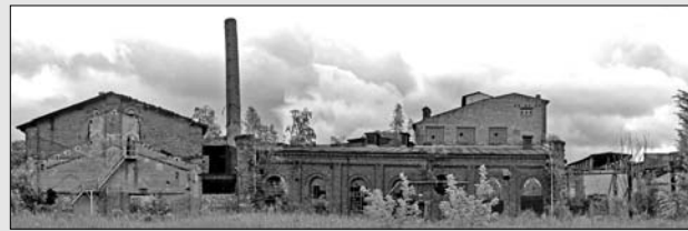
Gießerei I, Westansicht
