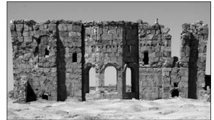
Die Ostfassade des Zentralbaus, mit den apsisflankierenden Resten der Türme, 2007.
