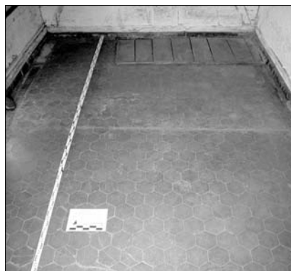
Abb. 3: Westlicher Raum (0.1) der Liegehalle mit Bodenbelag aus Mettlacher Fliesen von Villeroy und Boch.
