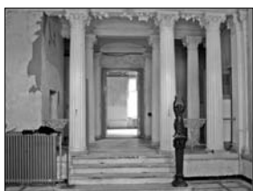
Oben: Obergeschoss, Blick in das verbaute Vestibül, 2007. Unten: Vestibül, Wand b, 2007.
