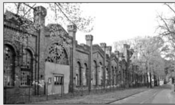
Gießerei I, Schauffassade zur Industriestraße, Ostansicht
