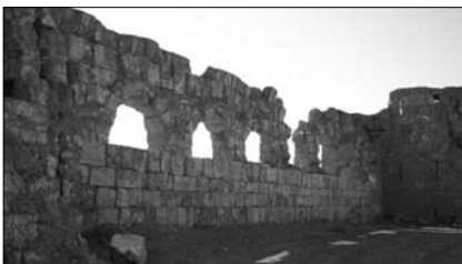
Abb.2: Rekonstruktionsversuch an der Westmauer (2001), zwischen Turm 26 und Turm 27, 2007.
