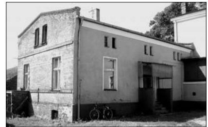
Stadtgut Blankenfelde, Haus 5, Nord- und Ostfassade, Juni 2007
