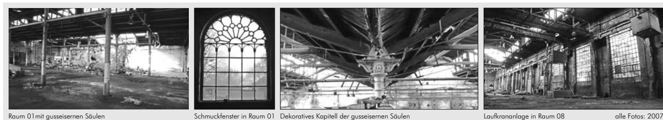
Raum 01 mit gusseisernen Säulen Schmuckfenster in Raum 01 Dekoratives Kapitell der gusseisernen Säulen Laufkrananlage in Raum 08 alle Fotos: 2007
