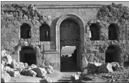
Abb.1, Südansicht der Nordtoranlage, 2007.
