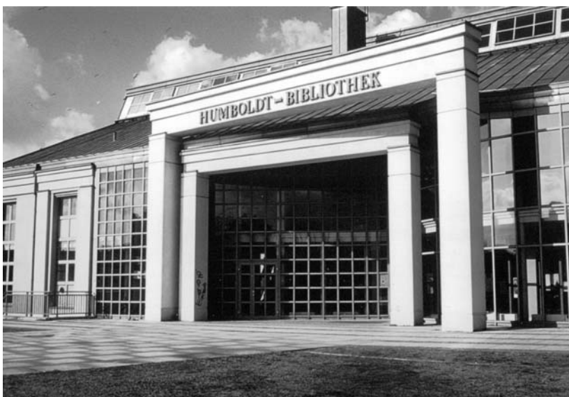
(Abb. 3) Eingang der Humbolt-Bibliothek. Das Stahl- und Betongerüst zum Innenraum ist freigelegt und dadurch ist die Eingangssituation betont. Charles W. Moore, Berlin.
