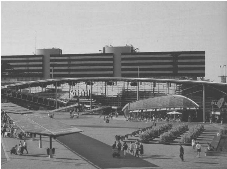
(Abb. 21) Die Ganzglasfassade zeigt sich dem Flughafengast als transparente, offen gestaltete Übergangszone zwischen Innen- und Außenbereich und schafft eine angenehm belichtete und somit freundliche Empfangsatmosphäre. Als überdimensionale, helle Lichtwand weist sie dem Ankommenden unmißverständlich den Weg und bietet einen unverstellten Ausblick auf den belebten Vorplatz mit Nahverkehrsterminals und Verweilzonen.
