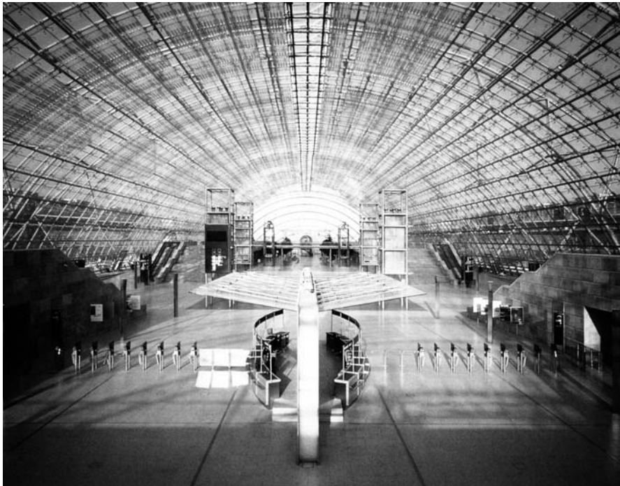
(Abb. 26) Stahl-Glas-Entree der Superlative. Empfangshalle Neue Messe, Leipzig. Architekten: von Gerkan, Marg und Partner.
