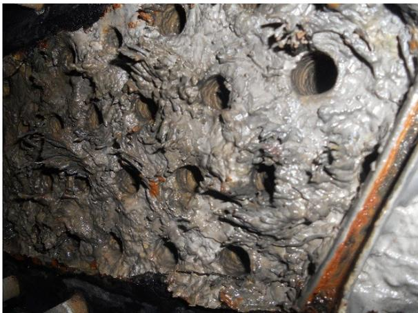
*Abbildung 70: Zugesetzte Rohrbündel*
