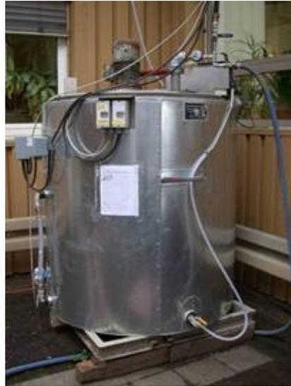
**Abb. 6-4: Herstellungs- und Dosierungsstation der Flockungshilfsmittellösung**
