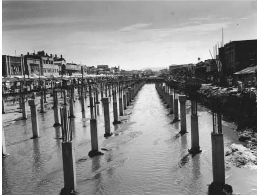
Abb.4.8 Bedeckung des Cheonggye Flusses mit Stahlbetonen im Jahre 1960
