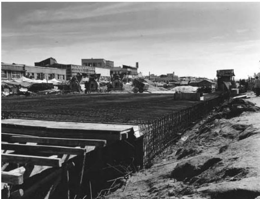
Abb.4.9 Bedeckung des Cheonggye Flusses mit Stahlbetonen im Jahre 1960
