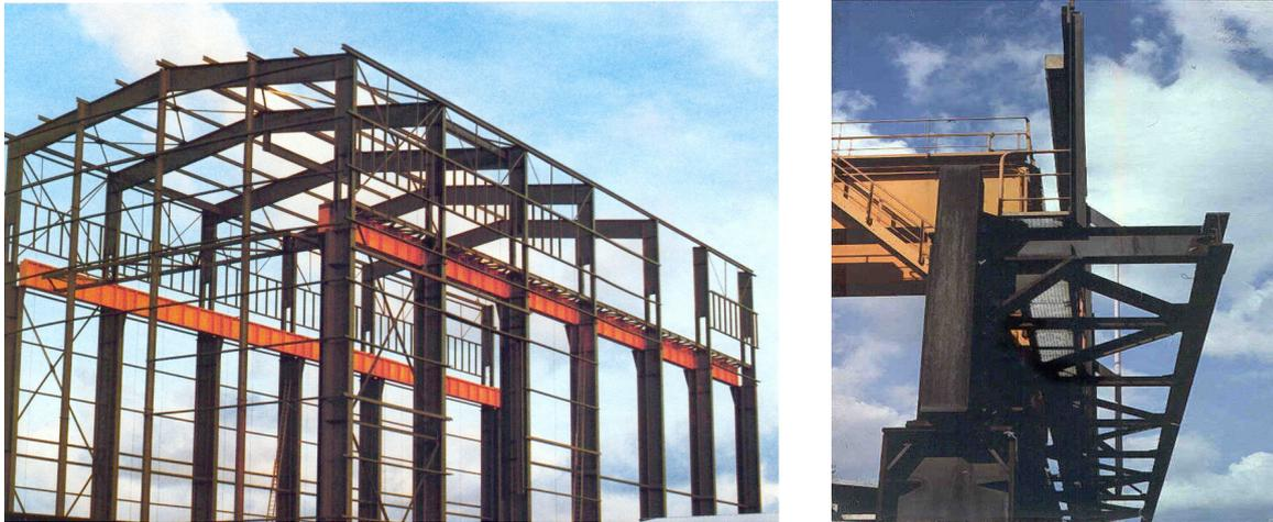
**Bild 2.1-4 Kranbahnträger mit horizontalem Verband am OG**
