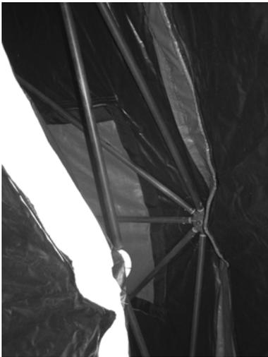
Abb.4.75 One-piece-technology. Blick zwischen die doppelwandige Membran auf die Konstruktion. Das Konstruktionssystem ist mit Außen- und Innenmembran verbunden. *Quelle: Draeger.*
