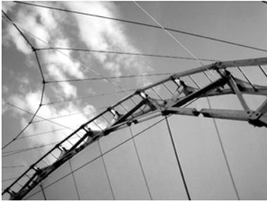
Abb.4.34 Konstruktionsbogen mit Abspannseil. *Quelle: Draeger.*
