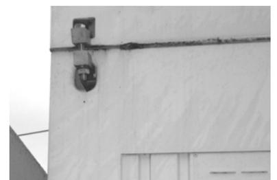
Abb.4.10 Stahlklammer zur Sicherung vertikaler Verbindungen von Containerbauten. *Quelle: Draeger.*
