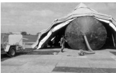
Abb.4.82 Das JS-Shelter wird mit Hilfe eines Ballons, der mit einem Gebläse innerhalb von wenigen Minuten mit Luft gefüllt wird, aufgerichtet (Air-lifting). Quelle: DHS Systems.
