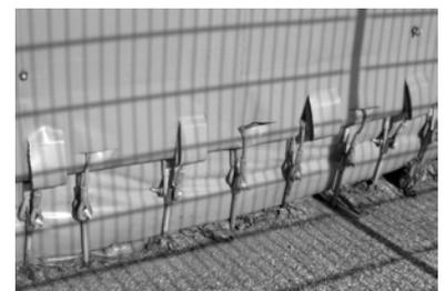
Abb.4.60 Neue Verankerung der durch Sturm beschädigten Seite der Ausstellungshalle "Meereswelten". *Quelle: Draeger.*
