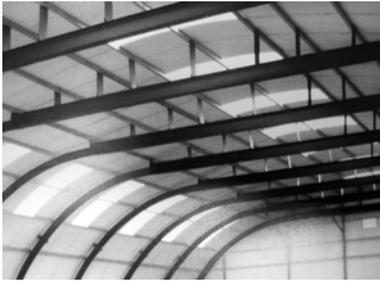
Abb.4.65 Konstruktion aus gebogenen IPE-Profilen. *Quelle: Frisomat.*
