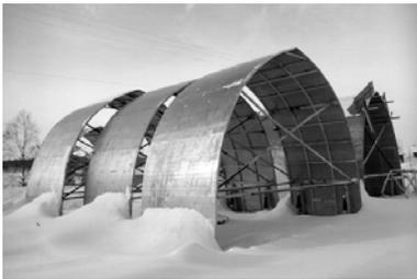
Abb.3.17 Jukkasjärvi Ice Hotel, Konstruktionsschalen. Mit Hilfe einer Schneemaschine wird künstlicher Schnee mit hohem Druck auf die Stahlform geschossen. Nach 2-3 Tagen ist der Schnee gehärtet und die Form wird entfernt. Architekten: Bergquist, Larsson, Nordström. *Quelle: Palmer, 1998.*
