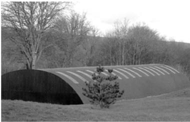
Abb.4.66 Lichtband aus Polycarbonat. *Quelle: Frisomat.*
