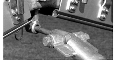
Abb.4.28 Der Aufbau der Leichtbauhalle erfolgt mit Hilfe einer Aufstellstange.
