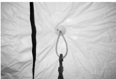
Abb.4.76 Verbindungsösen an der Innenmembran zur Befestigung von Beleuchtung und anderen Ausbauelementen. *Quelle: Draeger.*
