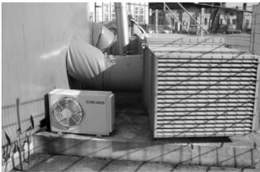
Abb.4.49 Wetterfeste Kompaktgebläseanlage mit Notstromgenerator. *Quelle: Draeger.*
