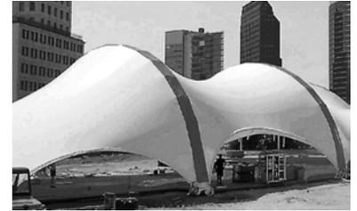
Abb.4.32 Vorgespannter Membranbau mit Bogenkonstruktion aus Aluminium von *Spann-Bau*. Quelle: *Horn*.
