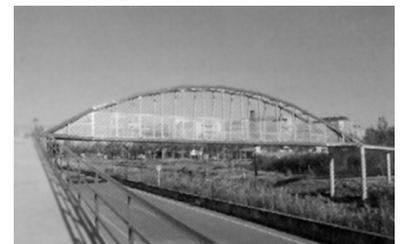
Abb.1.10 Lleida-Brücke aus GFK, Spanien. Die GFK-Brücke ist mit einer Spannweite von 38 m die längste GFK-Bogenbrücke der Welt. Das Gewicht beträgt nur 19 Tonnen. *Quelle: Knippers, 2003.*
