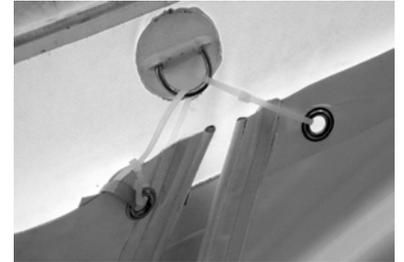
Abb.4.37 Fassadensystem aus Membrangewebe. *Quelle: Draeger.*
