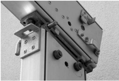
Abb.4.20 Steck-Schraubverbindung von Dachholm und Pfosten. Quelle: Draeger.
