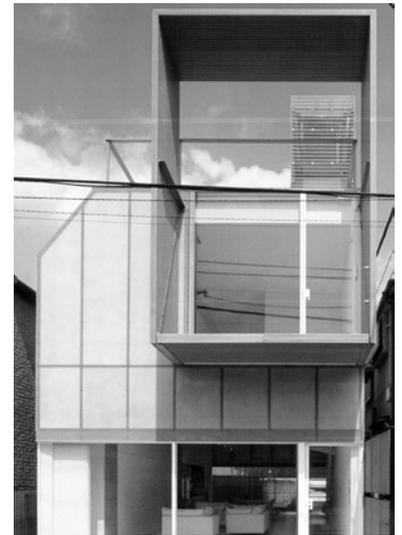
Abb.1.9 Plastic House, Architekt: Kengo Kuma. Außenmauern, Terrassen, Treppen und Bodenplatten bestehen bei diesem Wohnhaus in Tokyo aus glasfaserverstärktem Polyurethan (PU). *Quelle: Schleifer, 2006.*
