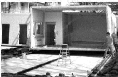
Abb.4.6 Dreipunktaufleger. Fundamentträger aus Kantholz. Erweiterungsbauten der Thorax-Klinik in Heidelberg. *Quelle: Algeco.*
