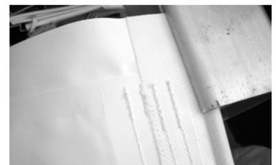
Abb.4.21-24 Verbindungssysteme zwischen Membran und Konstruktion (o.-u.): Steckhaken, Kunststoffgleiter, Kunststoffrollchen, Keder. *Quelle: 4.22 u. 4.24 Röder; 4.23 u. 4.25 Draeger.*
