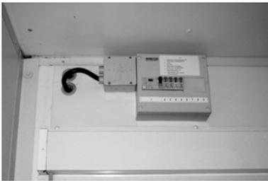
Abb.4.4 Plug-in-System. Außenanschluss (ohne Schutzkappe). *Quelle: Draeger.*
