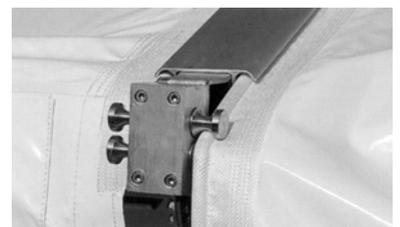
Abb.4.29-30 Nach Errichtung der Konstruktion wird die Dach-Wandmembran mit einem Keder an der Konstruktion befestigt.
