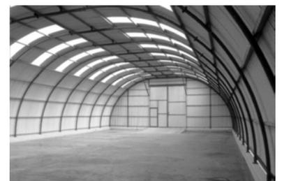
Abb.4.64 Halleninnenansicht. Alter Konstruktionstyp mit Rundrohr und T-Stück. *Quelle: Frisomat.*
