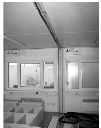
Abb.4.14 Innenausbau bei horizontaler Verbindung von Containern. *Quelle: Draeger.*
