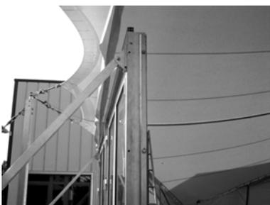
Abb.4.36 Festes Fassadensystem aus Aluminium. Als flexibler Übergang zwischen Dachmembran und Fassadenelement dient ein Dehngewebe. *Quelle: Draeger.*
