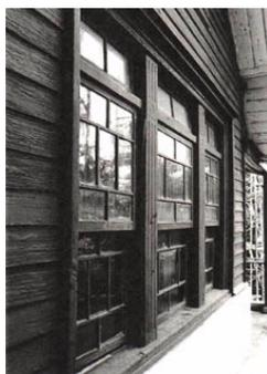
Abbildung 161: Verkleidung der Ostfassade „Holzschalung mit horizontalen, überlappenden Brettern“ (Quelle: Ebenda, S. 74.)
