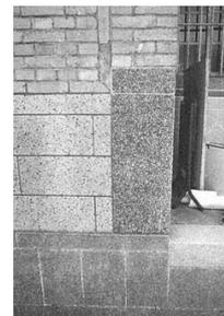
**Abbildung 43: Putzmörtel mit Kieselstein-Beimischung** (Quelle: Ebenda, S. 199.)
