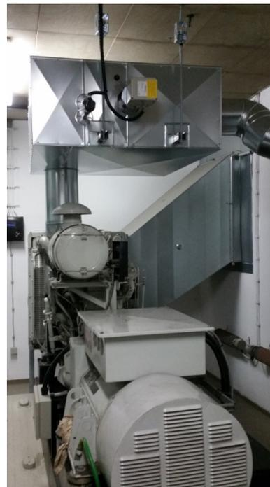
Bild 37: Notstromaggregat im Architekturgebäude mit Rußpartikelfilter
