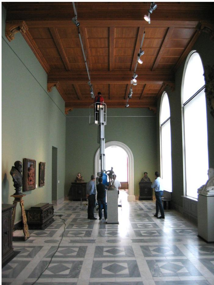
Abbildung 48: Installation der „High CRI“ LED-Strahler im Ausstellungssaal mit Seitenfenstern
