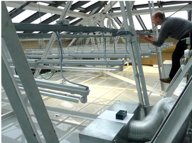
Abbildung 57: Glasdach mit integriertem Sonnenschutz, künstliche Ergänzungsbeleuchtung mit T5-Leuchtstofflampen und Staubdecke in der Kunsthalle Mannheim
