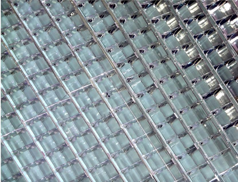
Abbildung 55: Tageslichtsystem mit Spiegelraster im SZR für die Dachschrägen der Kunsthalle Mannheim
