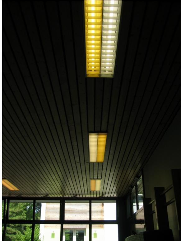
Abbildung 7: Beleuchtung in der Gymnastikhalle, Lampen mit unterschiedlichen Lichtfarben
