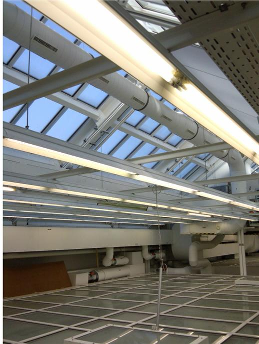
Abbildung 39: 80 W T5-Leuchtstofflampen als Ergänzungsbeleuchtung der Tageslichtdecke
