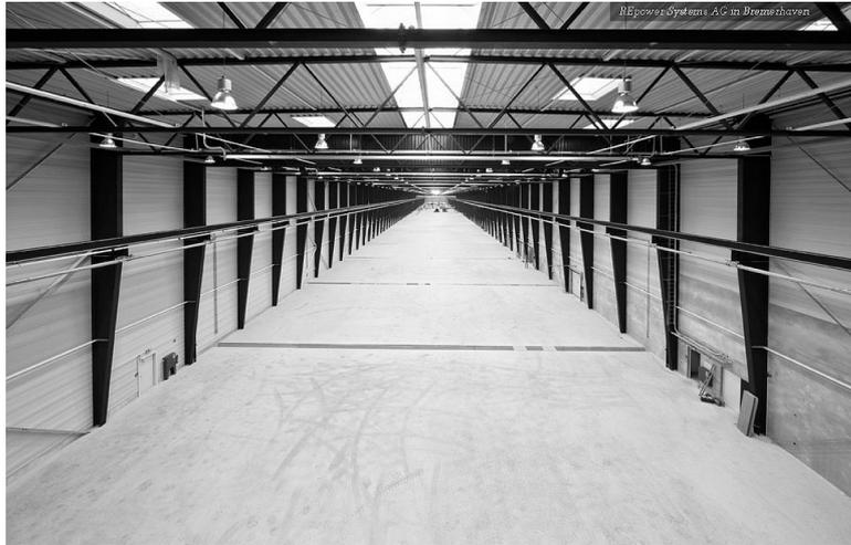
**Bild 2.16** Stahlhalle der Fa. Goldbeck mit Lichtband
