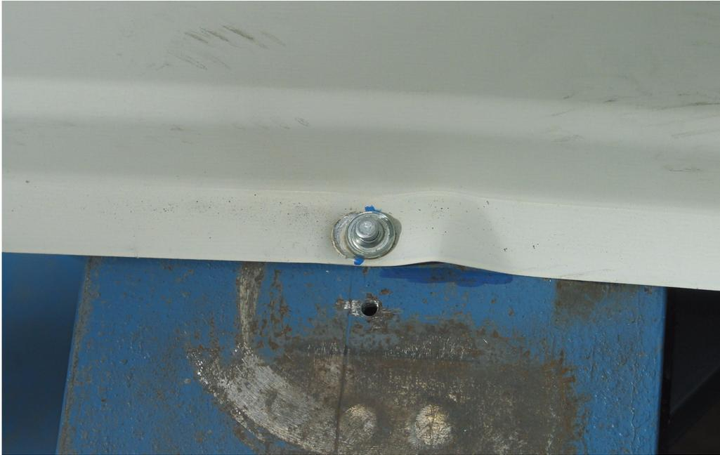
**Bild A.24** Verschobener Setbolzen mit Beule
