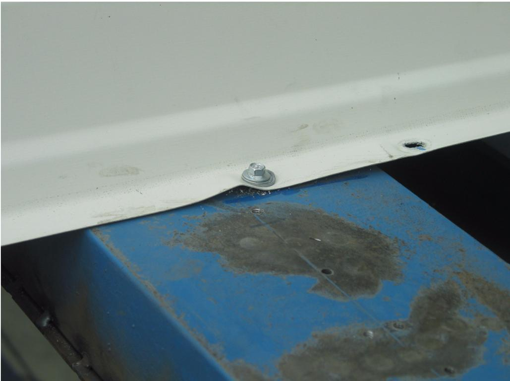
**Bild A.30** Bohrschraube mit herausgepresster Neoprenscheibe und Beule
