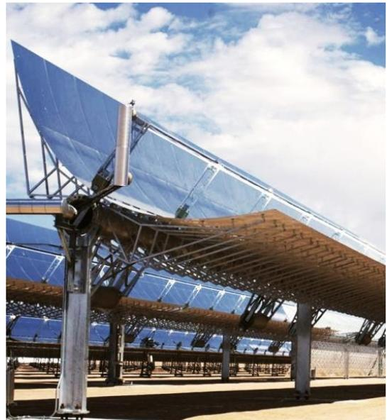
**Bild 8: Rinnenkollektoren mit komplexem Tragwerk**
