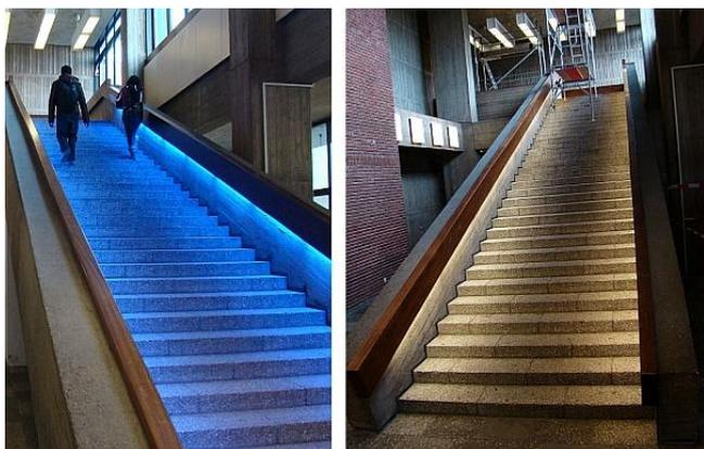
**Bild 31: Beispiel: Änderung der Treppenbeleuchtung mit besserer Erkennbarkeit der Stufen (Hauptgebäude)**
