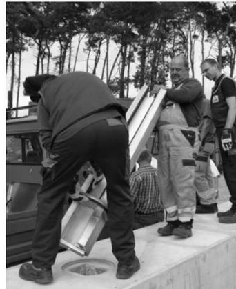
**Die weiterentwickelte „Schnellbaustütze“** (Bild 25 [II]).
