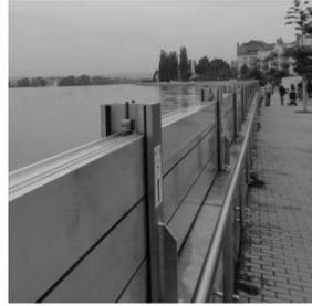
**Kombinationsmöglichkeiten mit mobilen Dammbalkensystemen** (Bild 23 [II]).
