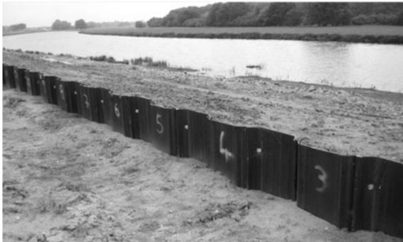
Bild 16: Sanierung und Ertüchtigung von bestehenden Hochwasserschutzanlagen [II].
