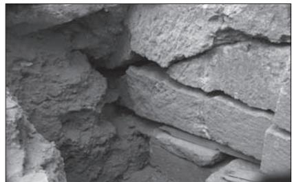
Basilika A, Ausschnitt des gerissenen Fundamentblocks unter der östlichen Säule der südlichen Mittelschiffarkade, 2009.
