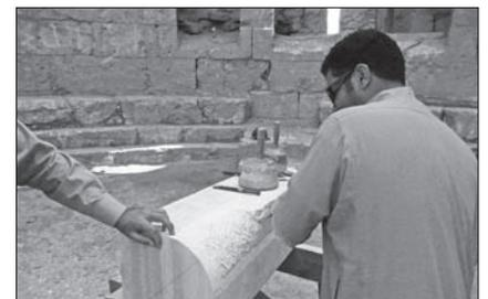
Abb 6. Basilika A, Neuanfertigung einer Säule aus Gipsstein durch einen angeleiterten Arbeiter aus Resafa, T. Horn 2009.
