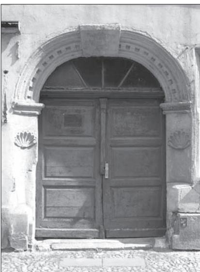
1. Ehemaliges Sitznischenportal des 17. Jh.s, welches im 19. Jh. durch Einfügen von zusätzlichen Werksteinen sowohl erhöht als auch verbreitert wurde, Mittelstr. 5, Wittenberg. Foto: T. Horn 2009.
