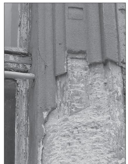
3. Überputztes Natursteingewände mit Diamantbossenprofil, der darüber liegende Putz imitiert das verdeckte Natursteingewände aus Sandstein, Kirchplatz 8, Wittenberg. Foto: T. Horn 2009.
