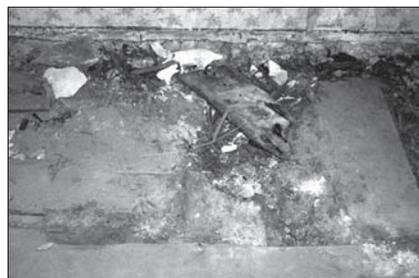
Caputh, Logierhaus, Biogener Befall der Fußbodenkonstruktion an den Außenwänden im Erdgeschoss, 2009.
