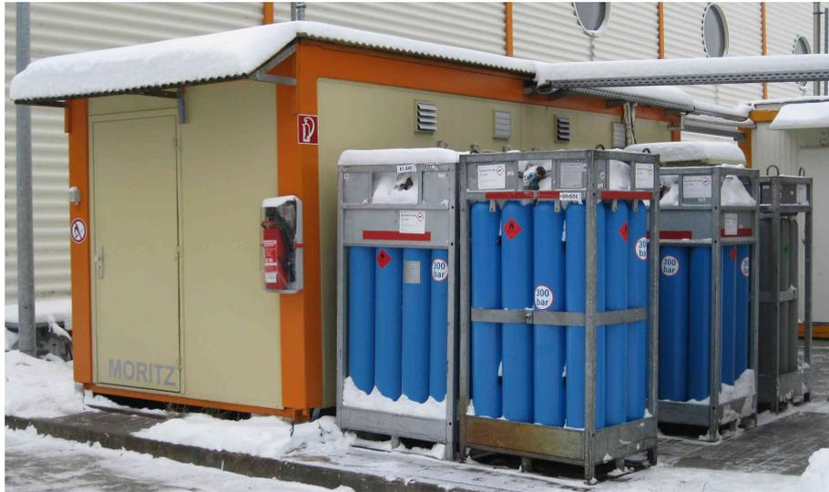
*Abb. 4.5: Gasbündel zur Versorgung des Teststandes mit technischen Gasen*
