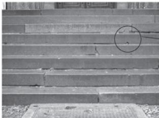
Abb. 4 - Treppe Ansicht, Befestigungslöcher
