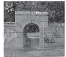
Nordmauer, fehlende Dachziegel, konstruktiver Riss, Graffiti
