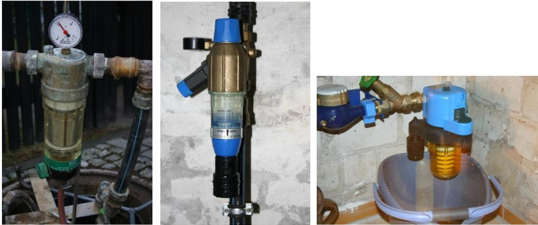
**Abbildung 2.4: Rückspülbare Partikelfilter: a) Einbau im Bereich von Hausanschlüssen (Mitte und rechts) bzw. b) Einbau direkt in der Hausanschlussleitung, zugänglich über einen Schacht (links)**
