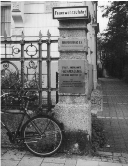
Abb. 100 (Links oben) und 101 (Links Unten): Grundstückseinfassung, München Schwabing, um 1900, Aufnahme 2001, rechts Gesamtansicht mit Fassade, links Detail. Typisches gut erhaltenes Ensemble mit pseudo-schmiedeeisernem Zaun aus Stahlblechpressteilen
