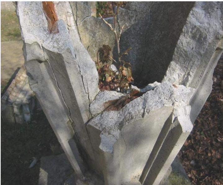
*Abb. 111: Detail einer gotischen Vase, Schloßpark Babelsberg, Aufnahme 2004. Erkennbar ist eine Arbeitsfuge zwischen zwei Teilstücken.*
