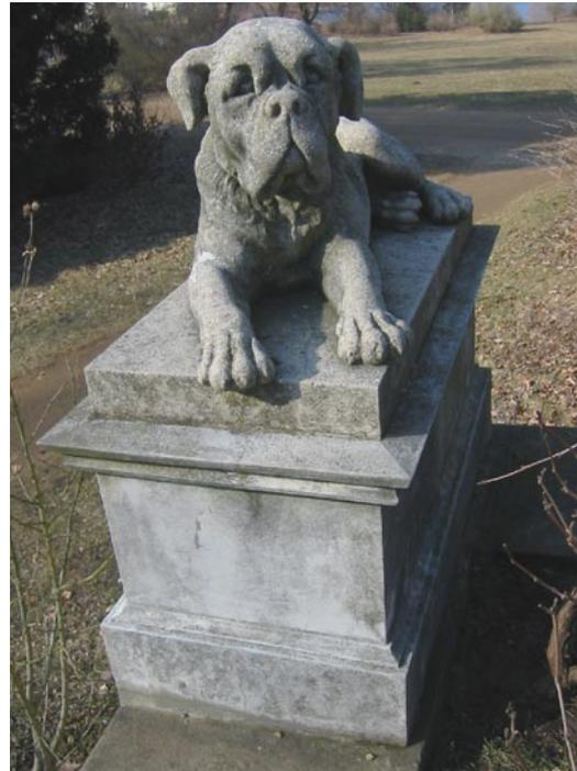
*Abb. 112 (links) Skulptur eines Setters oder Münsterländers, um 1856. Im Bereich des abgebrochenen Unterkiefers ist der Rest eines Bewehrungsstahls erkennbar, der u.U. auch von einem Reparaturversuch stammen kann.
