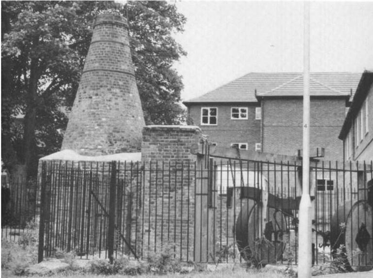
*Abb. 7: Erhaltene englische Zementmanufaktur der Fa. Pulham's, gegründet um 1840, Aufnahme ca.1980. Zu erkennen ist ein typischer englischer Schachtofen der ersten Generation.*
