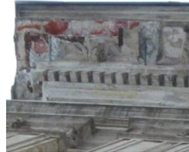
*Abb. 142: Bürgerpark Pankow, Römisches Tor; Untersicht des Hauptgesimses mit Fehlstellen und sichtbarer Tragkonstruktion aus Flacheisen*
