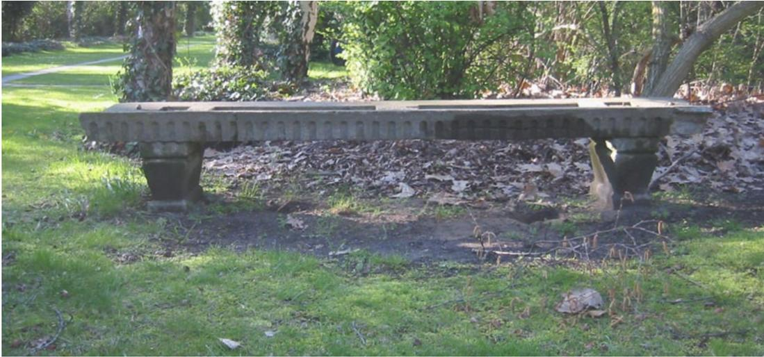
*Abb. 110: Sitzbank aus bewehrtem Beton um 1920 in der Formensprache des 19. Jahrhunderts, Hauptfriedhof Reinickendorf, Berlin. An der rechten Ecke der Bank ist eine Abplatzung mit freiliegender Bewehrung erkennbar.*
