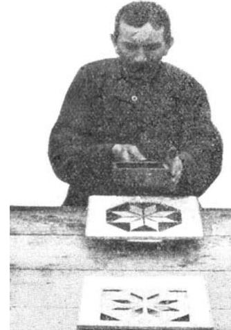
*Abb. 40: Herstellung farbig gemusterter Platten mittels Einstreuschablonen, 19.Jahrhundert*
