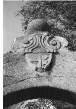
*Abb. 99: Detail Torbogen, Kombination unterschiedlicher Elemente (örtliche Herstellung und Fertigteile) aus unterschiedlicher Betonzusammensetzung. Das Wappenemblem besteht aus einem Beton mit hohem Feinmörtelgehalt.*
