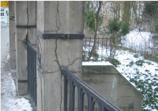
Abb. 177: Pergola an der Grabbeallee, um 1925, Aufreibung und Rissbildung durch einbindende Geländergurte, provisorische Sicherung durch Bandstahlumwehrungen
