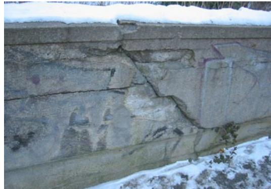
Abb. 178: Setzungs- bzw. Dehnungsriß im Bereich der Mauer zwischen Puttengruppe und Pergola.
