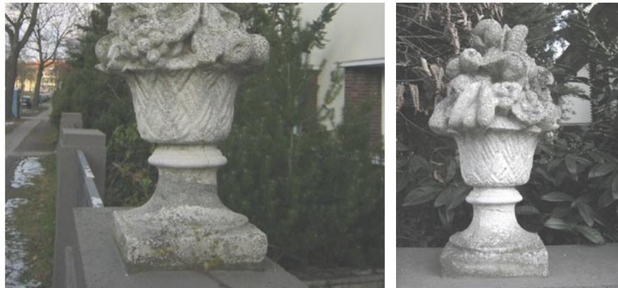
*Abb. 106 und 107: Historische Betonvase mit Fruchtschmuck als Spolie im Bereich einer Grundstückseinfassung, Berlin Dahlem, frühes 20. Jahrhundert. Erkennbar sind Risse des Vasenkörpers und verstärkte Oberflächenverwitterung im Bereich des exponierten Obstschmucks.*
