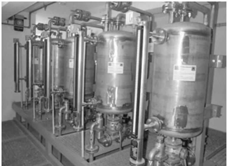
Sichere Kraftstoffversorgung für Motorprüfstände: Tagestanks mit Überfüllsicherung und Brandschutzeinrichtungen (Foto: SDU)
