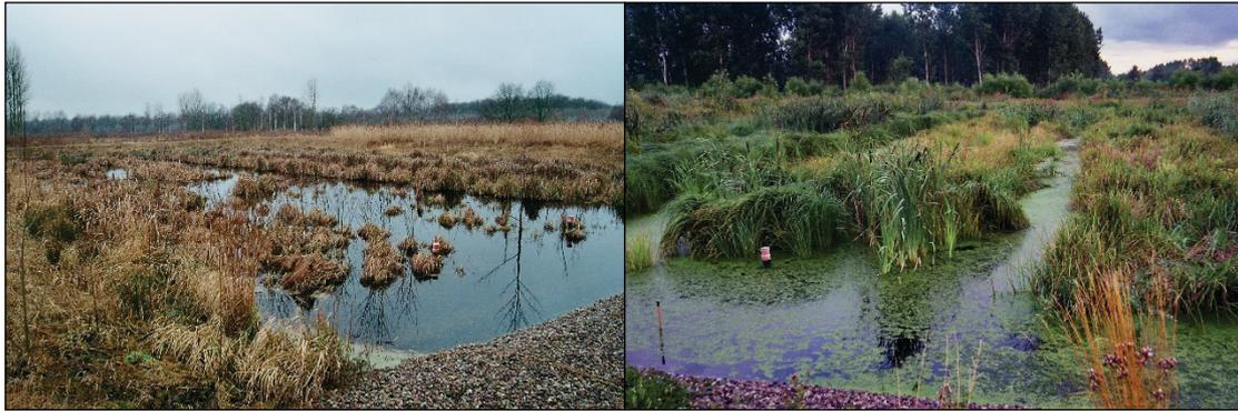
Abb. 3-6: Sandfilter mit Längsgräben im Winter (links) und im Sommer
