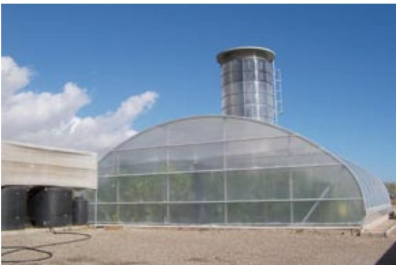
Das geschlossene Gewächshaus in Almeria mit Kühlschacht zur Rückgewinnung von Wasser (FOTO BUCHHOLZ)
