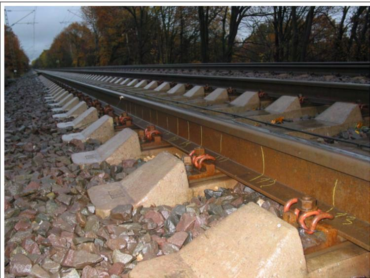
Abb. I.9: Ansicht der MS **F**. Die Schotter-Verschäumung an den (darüber hinaus baugleichen) MS **G** und **H** ist nicht sichtbar.
