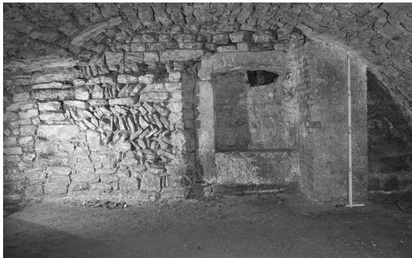
Abb. 4: Tonnengewölbter Kellerraum K.010.
