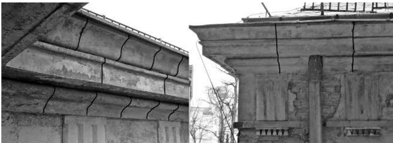
Abb. 12: Gebälk am Gerlach-Bau aus Terrakotta (links) und Wolff-Bau aus Kunststein (rechts). Fugenschnitt zur Verdeutlichung nachgezeichnet.
