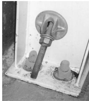
Abb.5.38 – Konstruktive Lösung für Anschluss Diagonale an Stütze ohne Knotenblech (Bildquelle: [Dig08])
