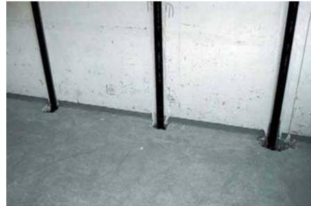
Abb.4.30 – Vertikale Anordnung der Lamellen (Bildquelle: [Str08])
