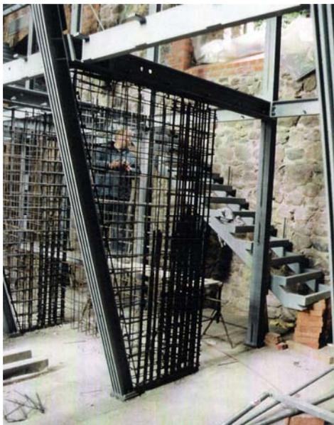
Abb.2.4 – Variante Stahlbetonausfachung in Ortbeton (Bildquelle: Prof. Dr.-Ing. E. Widjaja)
