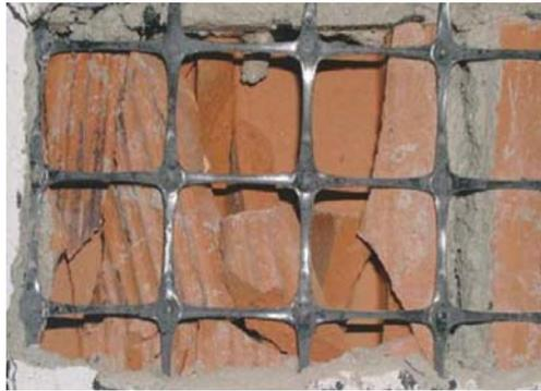
Abb.4.13 – Umfassung durch Gitter
