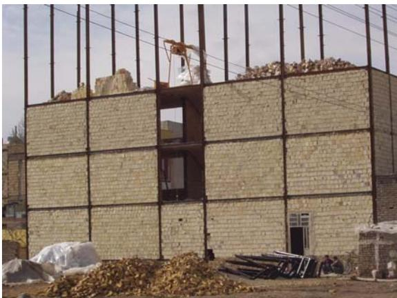
Abb.1.1 – Ausgefachter Stahlrahmen im Iran
