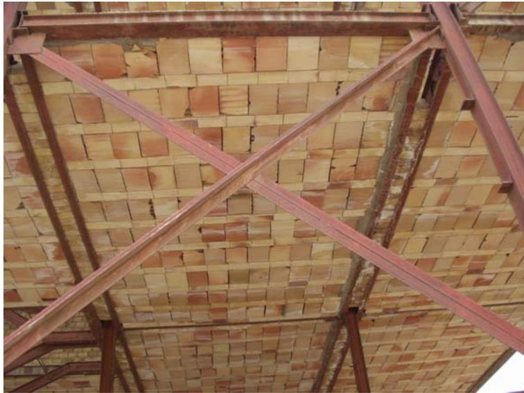
Abb.5.56 – Gekreuzte Diagonalen ohne Verwendung eines Knotenblechs im Kreuzungspunkt
