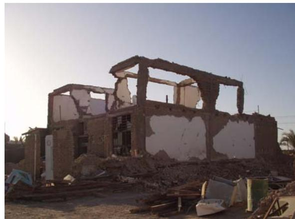
Abb.3.2 – Zerstörte Ausfachungen
