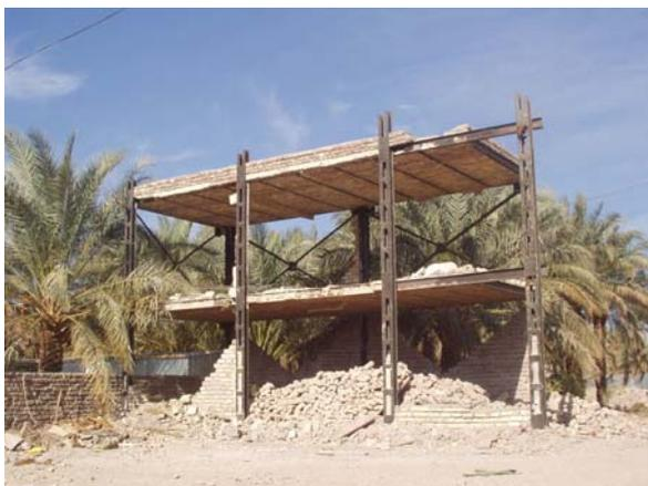
Abb.3.1 – Aus Rahmen herausgefallene Ausfachungen
