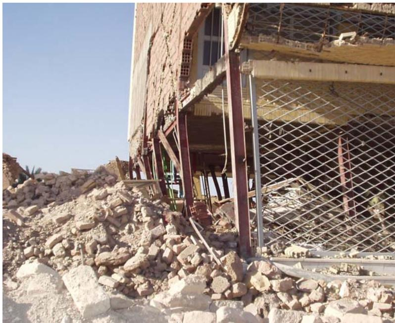
Abb.5.2 – Zerstörte Ausfachung [Bildquelle: Davood Urojzadeh]
