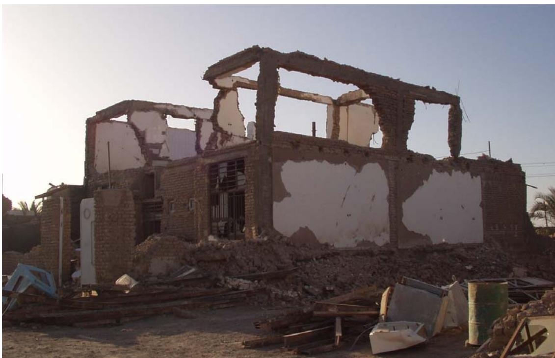
Abb.4.1 – Zerstörte Ausfachung (Bildquelle: Davood Urojzadeh)
