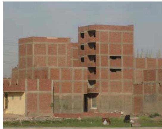
Abb.1.2 – Ausgefachter Stahlbetonrahmen in Ägypten
