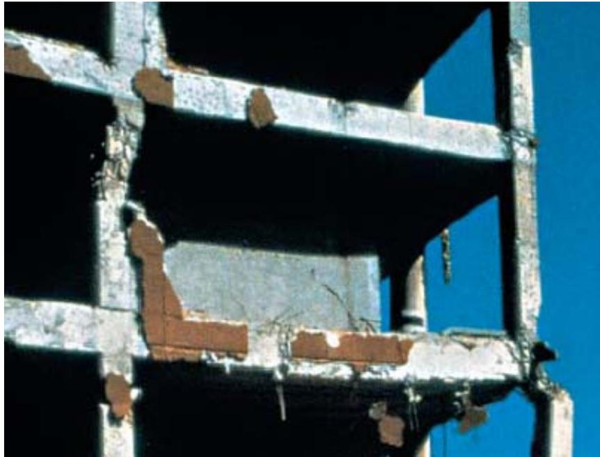
Abb.1.3 – Schubversagen der Stützen (Bildquelle: [Bac02a])
