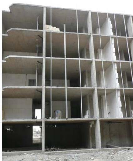
Abb.4.8 – Variante mit senkrechter Anordnung von Flachstählen (Bildquelle: Jan Grunwald)
