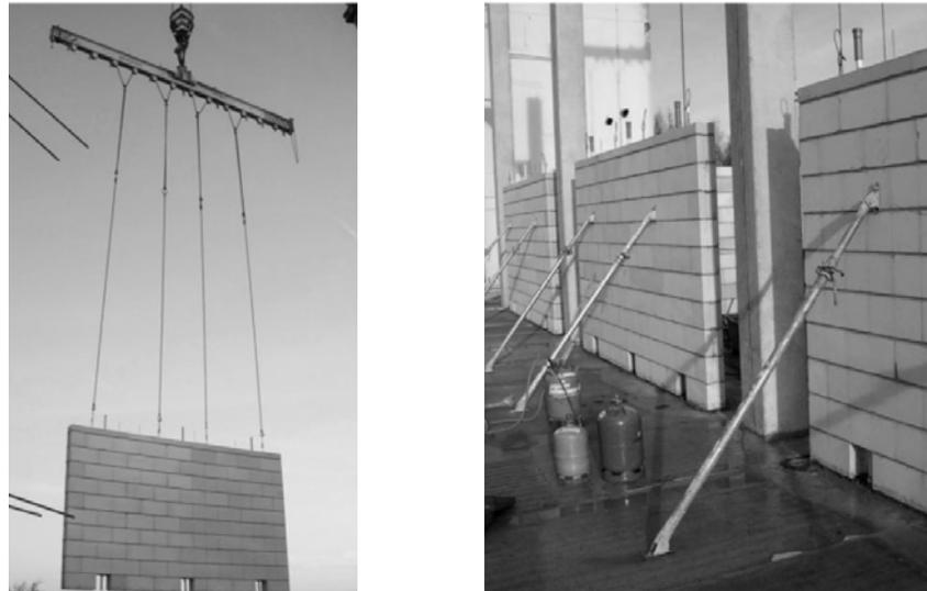
Abb.4.24 – Vorgefertigte vorgespannte Mauertafeln aus Kalksandstein (Bildquelle: [Bud06a])
