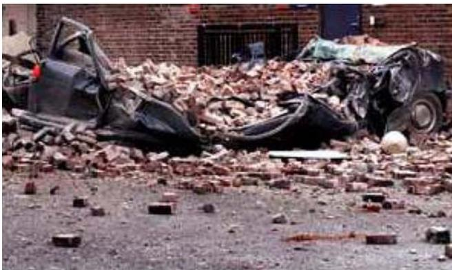
Abb.4.4 – Abgestürzte Ausfachung (Bildquelle: [Moj07])
