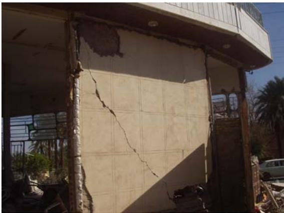
Abb.1.4 – Ausfachtung mit Diagonalriss
