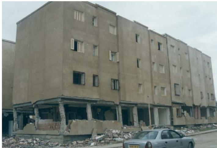
Abb.2.92 – Stützenmechanismus im Erdgeschoss (Bildquelle: Djillali Benour, University of Bab Ezzour, Algeria)
