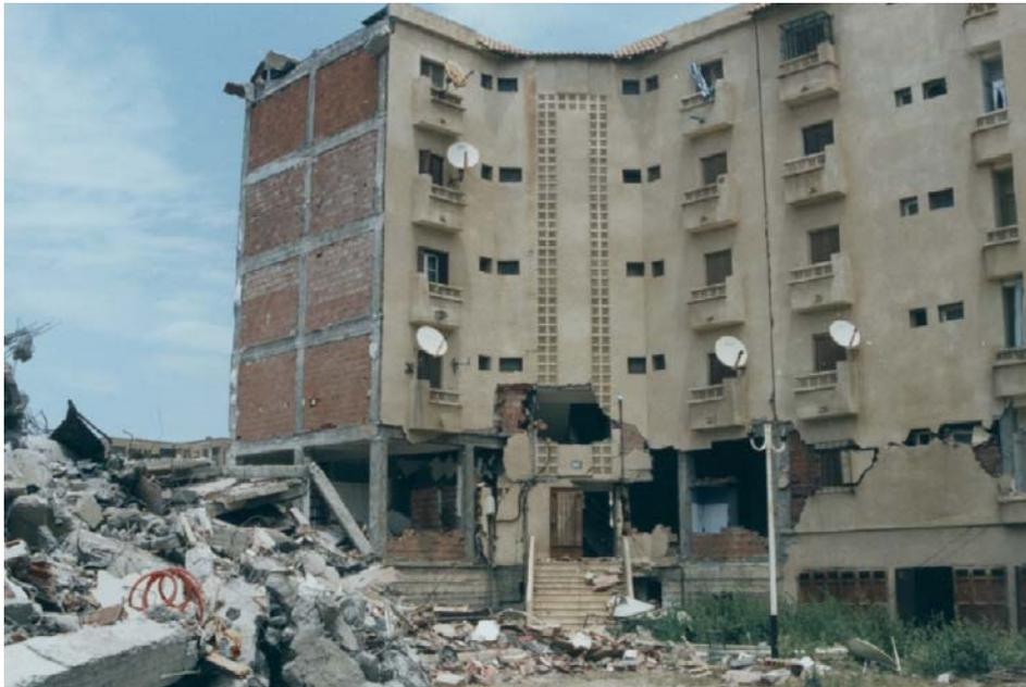
Abb.2.108 – Zerstörte Ausfachungen im Erdgeschoss eines fünfgeschossigen Wohnhauses in Algerien (Bildquelle: Djillali Benour, University of Bab Ezzour, Algeria)
