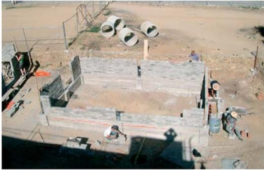
Abb.2.115 – Mauerwerk vor Betonieren der Stützen
