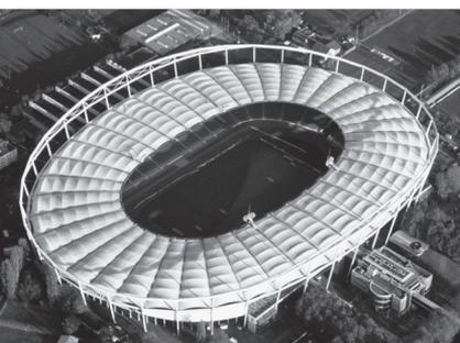
Abb. 9 Ringseldach des Gottlieb Daimler Stadium, Stuttgart, Deutschland 1993.
