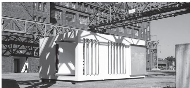
Abb 9 Die Polycarbonat-Lamellen sind mit der Holzkonstruktion verklebt und mit einer PUR-Beschichtung versiegelt.
