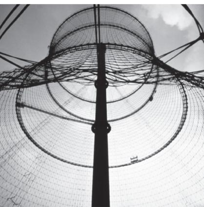
Abb. 8 Seilnetzkühlturm (im Bau), Schmehausen, Deutschland 1974.
