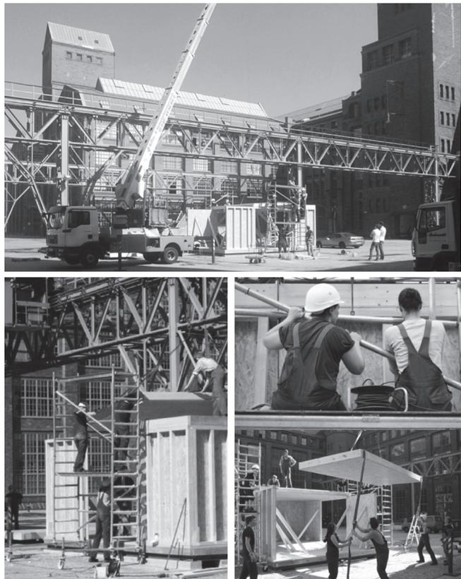
Abb. 5 Studierende beim Errichten des Pavillons in Holztafelbauweise.
