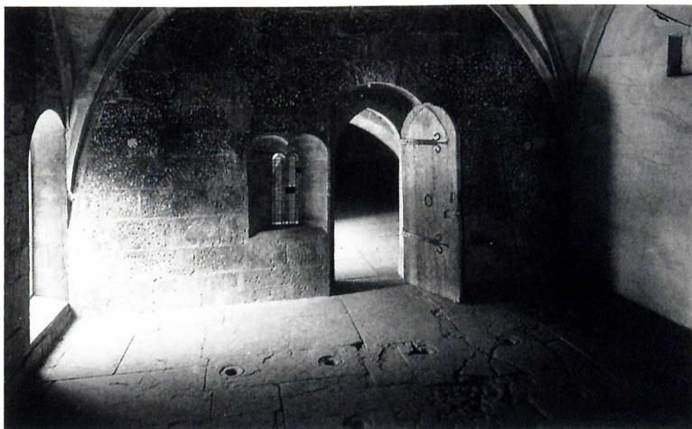
Abbildung 12 - Luftauslässe der Calefactoriumsheizung im Kloster Maulbronn (Aus: Knapp, 1997, S. 153.)
