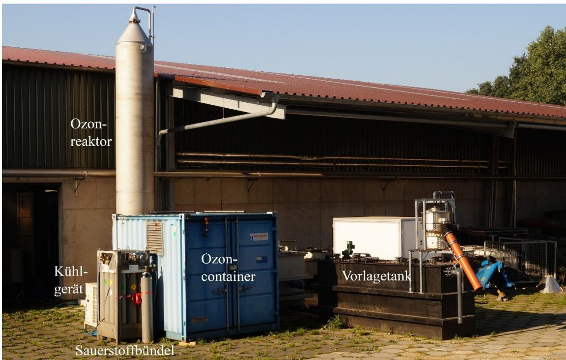
Abbildung 3-8: Aufnahme der Ozoneinheit am Standort 1 im Pilotmaßstab
