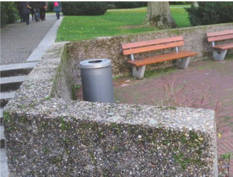
**Waschbetonmauern** variieren je nach Farbe und Korngröße der Kiesvorsätze im Aussehen. Erst die industrialisierte Fertigung hat zu der allgegenwärtigen Uniformität geführt. Waschbetonmauern sind fast immer ohne eine Abdeckung ausgeführt.
