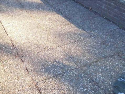
**Waschbetonplatten** mit unterschiedlichsten Kiesvorsätzen sind ein charakteristisches Merkmal von Anlagen, die in den 1960er-Jahren entstanden.
