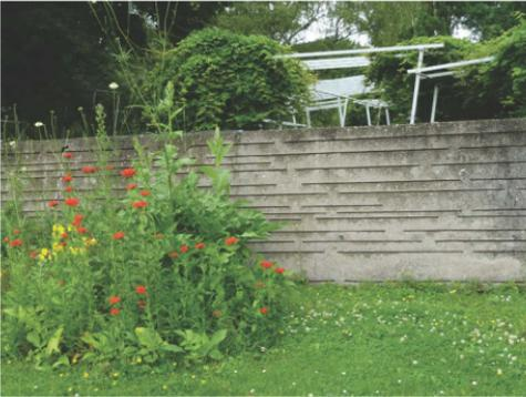
Durch das nachträgliche Bearbeiten des **Ortbetons**, z. B. durch Sandstrahlen, oder durch die Art der Schalung, z. B. mit profilierten Brettern, erhalten diese Mauern eine künstlerisch gestaltete Oberfläche.
