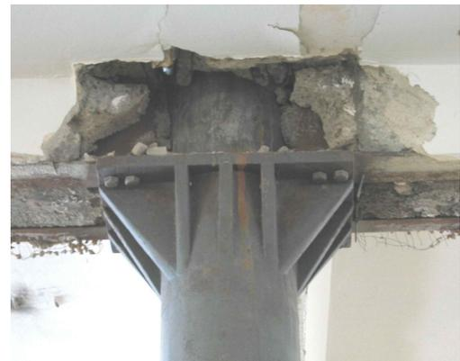
**Abb. 5.40:** Stützenkopf im Geschossbau
