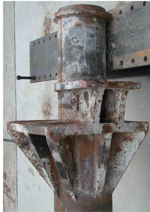
**Abb. 5.42:** Beispiel für eine Stützenkopfausbildung mit Stecksystem
