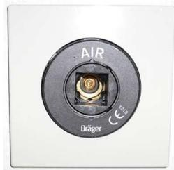
Abb. 6-42 Unterputz-Gasentnahmestelle nach DIN 13260
