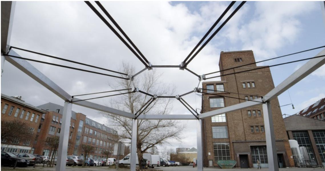
**Abb. 2.2** Prototyp eines Ringseildachs an der TU Berlin mit Zuggliedern aus CFK [93]
